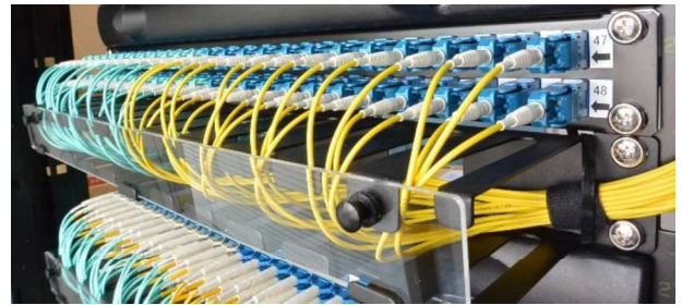
【高密度配線用コード】 外径2mmΦコードに光ファイバが2本入っています
