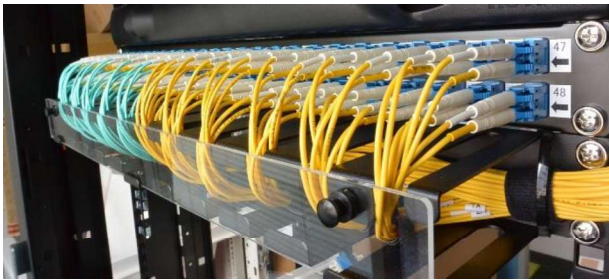
【従来の2芯めがねコード】 2mmΦ×2本（外径2×4mm）
